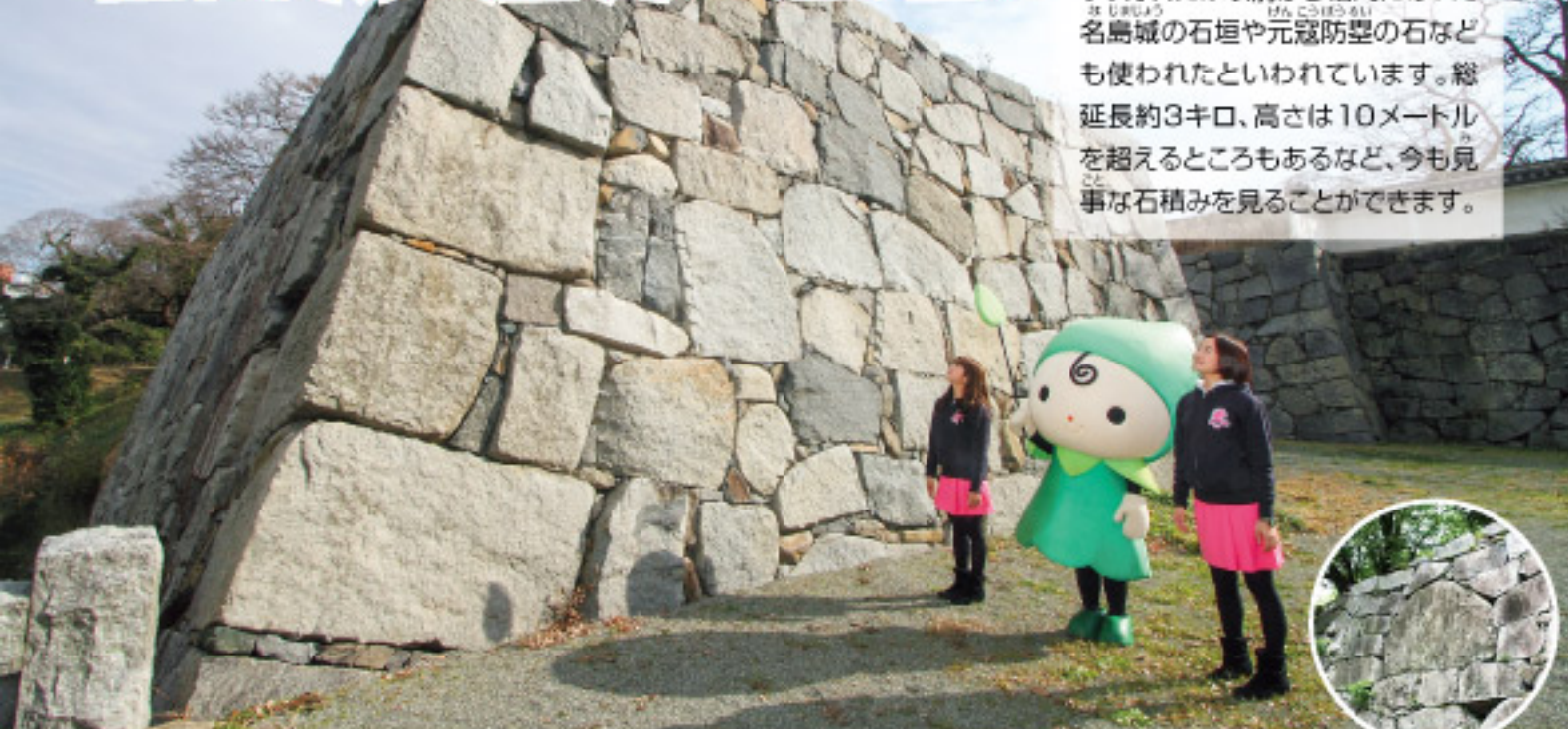
平成17年の福岡県西方沖地震により崩壊の危険があるとされた上之橋御門石垣。平成26年、解体修理が行われた。
