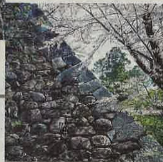
B類。出隅は花崗岩の割石を使った算木積み
