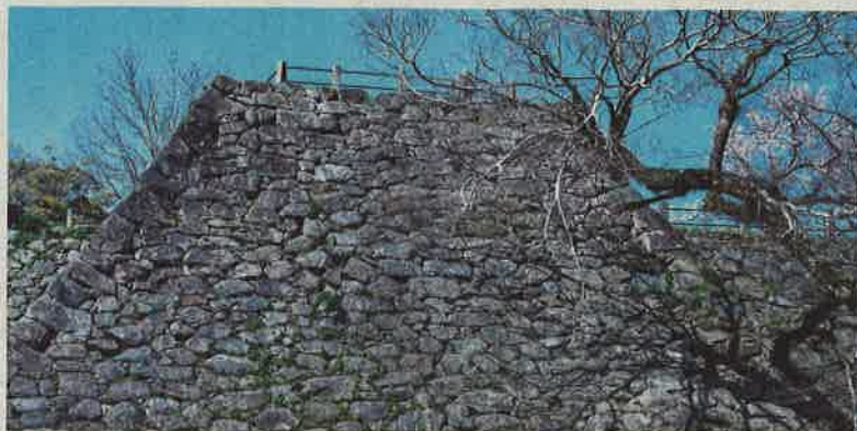
A類。野面石(加工していない石)を積んだ「布目崩し積み」。出隅(角)は、石の長辺と短辺を互い違いに組んだ「算木積み」だが石の大きさがふぞろいで未発達
